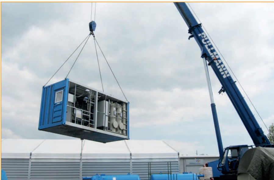
EnviModul-Anlage zur dezentralen Abwasserbehandlung für eine Kosmetikproduktion in Osteuropa.
