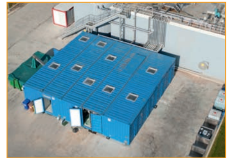
EnviModul-Anlage zur dezentralen Abwasserbehandlung für eine Kosmetikproduktion in Osteuropa.
